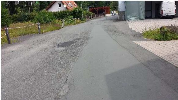
Da der vorhandene Knotenpunkt (Einmündung Badstraße/Hüttenweg) durch die Steilheit und den ungünstigen Anschlusswinkel des anschließenden Hüttenwegs schlecht befahrbar war, wurde diese Einmündung (ohne Grunderwerb) soweit möglich für den Verkehr verbessert und optimiert.
