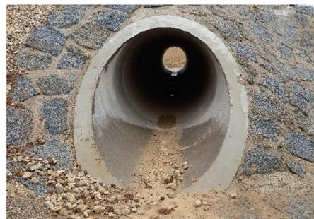
Im Vorfeld der Maßnahme wurden Hochwasserberechnungen durchgeführt. Als Maßnahmen für den Hochwasserschutz errichtete man daher zwei neue Flutdurchlässe (DN1000).
