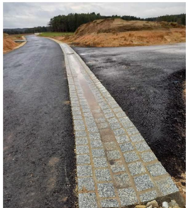
Für die breitflächige Entwässerung wurden entsprechende Mulden und Böschungen am Fahrbahnrand errichtet.
