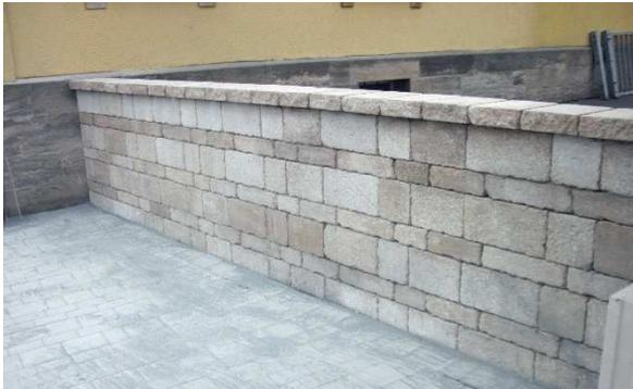
Im ähnlichen Stil wie die Pflasterverlegung wurden mehrere Stützmauern zur Sicherung der Gehwege vor anstehenden Böschungen neu errichtet.
