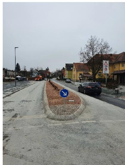
Um eine Vergleichmäßigung und Beruhigung des Verkehrs auf der St2460 erhalten zu können, wurde die Fahrbahn im südlichen Kreuzungsbereich räumlich durch einen ca. 80m langen Fahrbahnteiler getrennt, der von der Gemeinde Bindlach regelmäßig intensiv bepflanzt wird.
