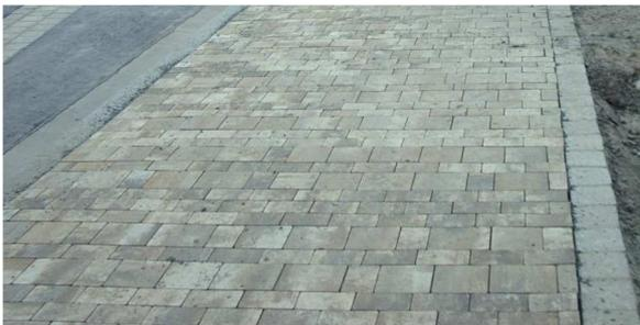
Die Gehwege wurden mit Betonpflaster neu aufgebaut und gestaltet.
